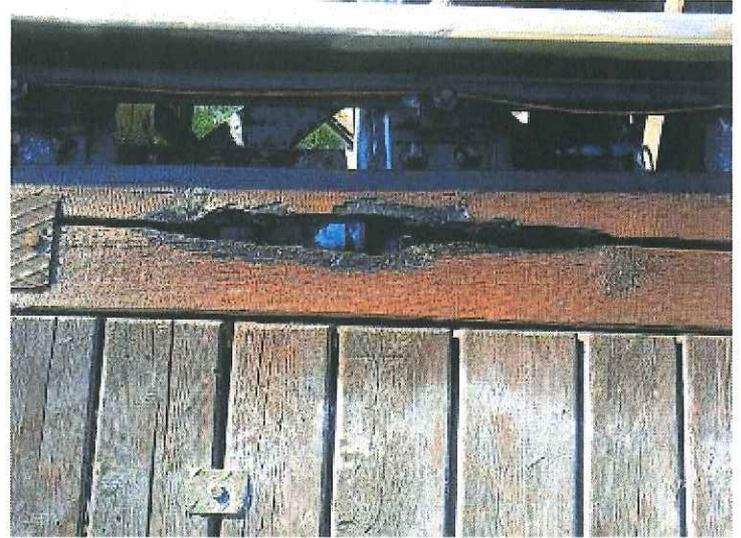
Vermutlich durch ein glühendes Eisenteil, welches sich in den Holzteilen der „Trattenbachbrücke“ verklemmte, kam es dort zu einem Brandausbruch.
